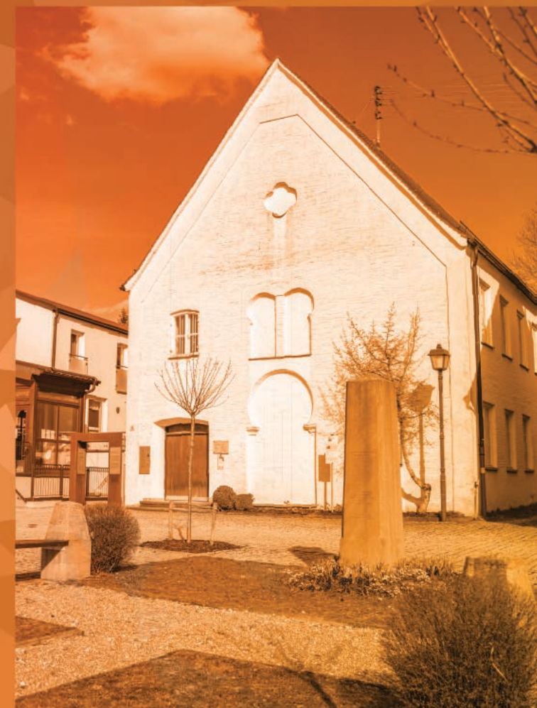
Westfassade nach der Sanierung 1988 (Foto von 2021)
